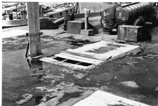
写真2. 糞尿貯槽 (第2例)
