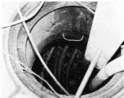
写真1. マンホール (第1例)
